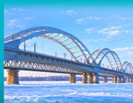
สะพานรถไฟบึงโจว
