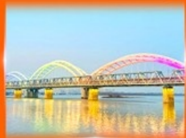
สะพานรถไฟพินโจว
