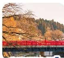
สะพานนากะบาชิ
