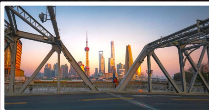
สะพานวอไปตู้
