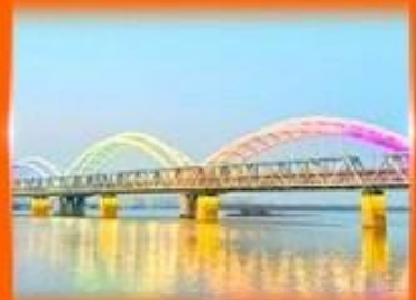
สะพานรุทโฟบินโจว
