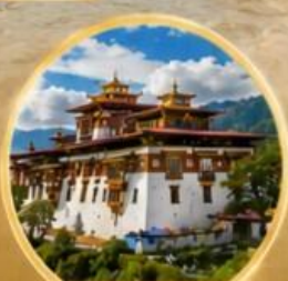
พูนาคาซอง
