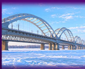
สะพานรถไฟป๋นโจว
