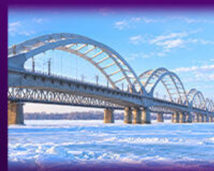
สะพานรถไฟโปนโจว
