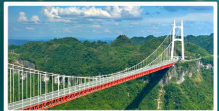
สะพานอายจ้าย
