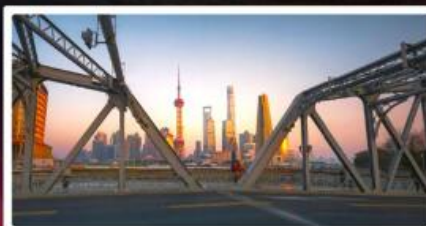
สะพานวอไปตู้
