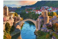
สะพานเก่า Mostar
