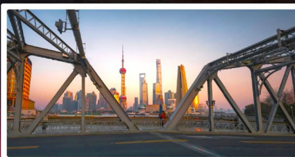
สะพานไวปี้ดู่
