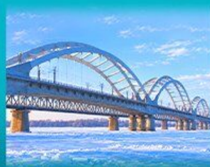
สะพานรถไฟบึงโจว
