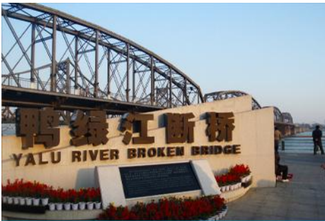
สะพานขาด
