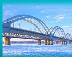
สะพานรถไฟบึงโจว
