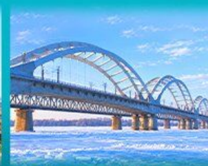
สะพานรถไฟบึงโจว
