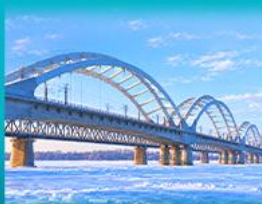
สะพานรถไฟป๋องโจว
