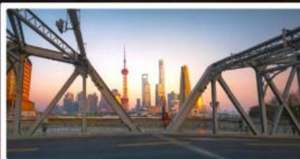
สะพานวอไปตู้
