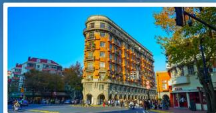
ถนนอันฝู & อาคารอู่คัง
