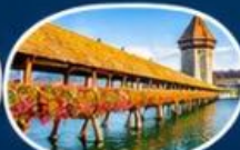
สะพานไม้อาเปิล
