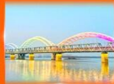
สะพานรถไฟผืนโจว
