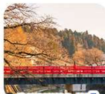
สะพานนากะบาชิ
