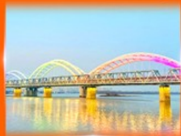
สะพานรถไฟผืนโจว
