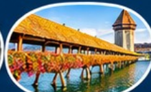
สะพานไม้อาเป
