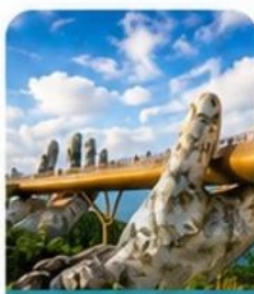
สะพานมือสีทอง
