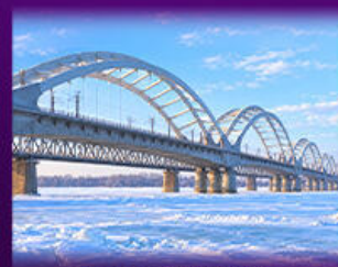
สะพานรถไฟป๋นโจว
