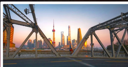
สะพานไวปี้ดู่
