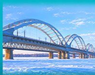
สะพานรถไฟบึงโจว
