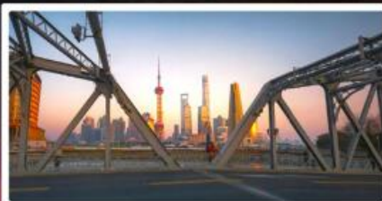
สะพานไวปี้ดู่
