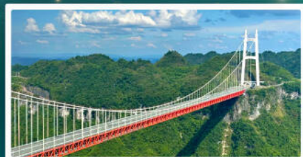
สะพานอายจ้าย
