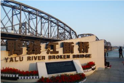
สะพานขาด
