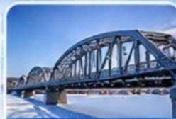
สะพานรถไฟร้อยปีปิงโจว
