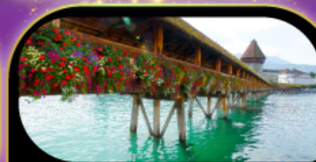
สะพานไม้ชาเปล คูลินท์
