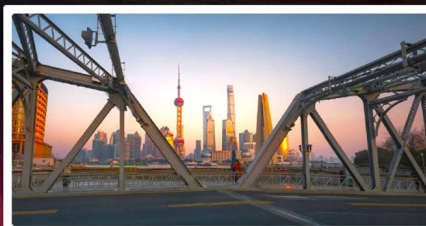
สะพานไวปู้
