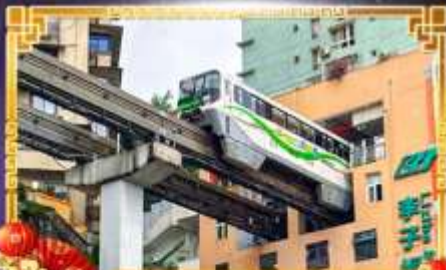
รถไฟฟ้า-ลู่ติง
