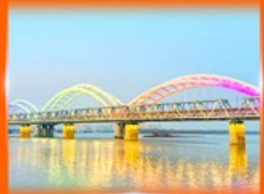
สะพานรถไฟผืนโจว
