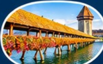
สะพานไม้อาเป
