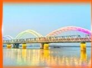
สะพานรุทโฟบินโจว
