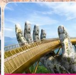
สะพานมือสีทอง
