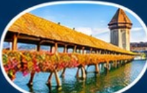
สะพานไม้อาเป
