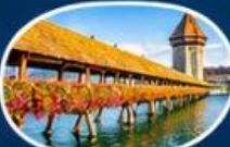
สะพานไม้อาเพล
