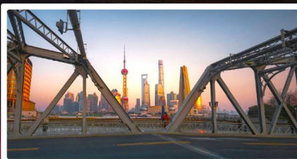
สะพานไวไปตู้
