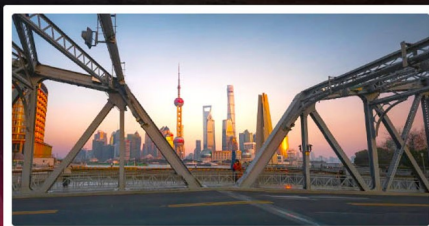
สะพานไวไปคู้
