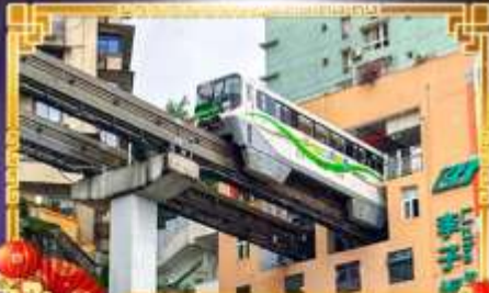
รถไฟฟ้า-ลู่ติง
