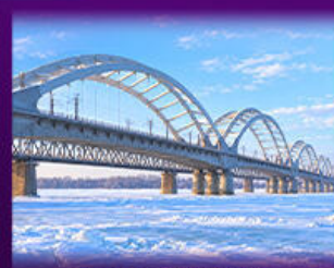
สะพานรถไฟป๋นโจว
