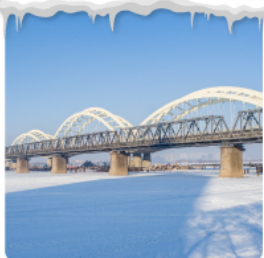
สะพานปิงโจว
